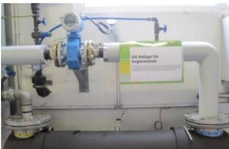
Seit 2007 wird das gesamte Regenwasser aufgefangen. Es wird in einem Sammelbecken mit einem Fassungsvermögen von 300 m<sup>3</sup> gespeichert. Anschliessend wird das Regenwasser durch eine UV-Anlage entkeimt, so dass es sicher in verschiedenen Betriebsbereichen als Waschwasser (z.B. Reinigung von Maschinen oder Böden) eingesetzt werden kann. Diese Methode ermöglicht es uns, jährlich etwa ein Viertel des gesamten Wasserbedarfs einzusparen.
